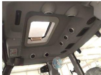
Figura 3-59 Salidas de aire del aire acondicionado
