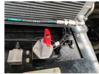
Figura 3-39 Interruptor de alimentación principal
