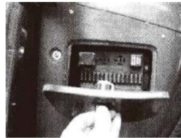
Figura 3-84 Caja eléctrica central
