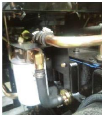
Figura 5-8 Filtro de aceite de retorno
